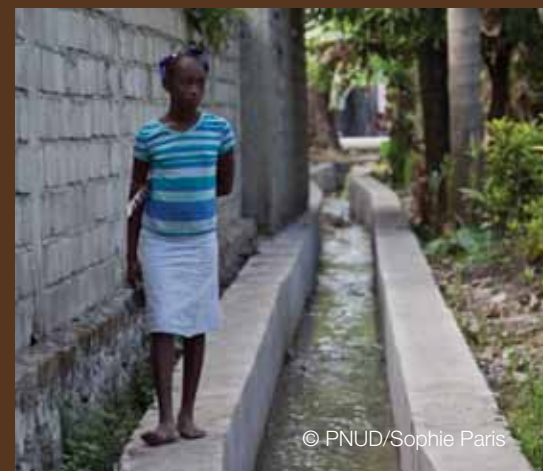
Canal nettoyé, les Cayes.
