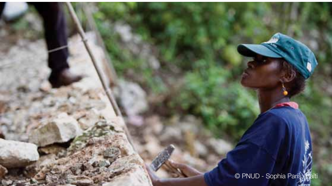
Nettoyage de canaux
